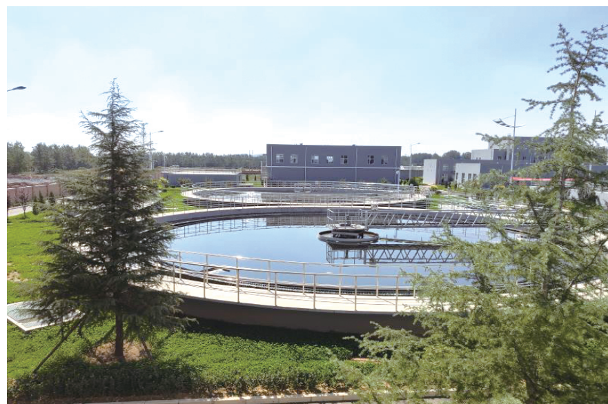
高平第二生活污水处理厂
